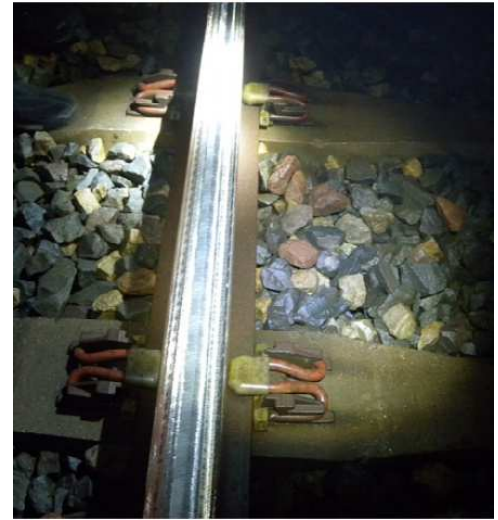
Rail après meulage
