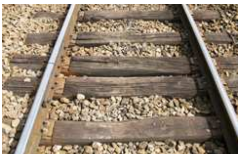
Rails courts sur traverses bois
